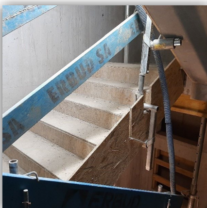
Bortnice na klatkach schodowych Warszawa Wilanowska R4R
