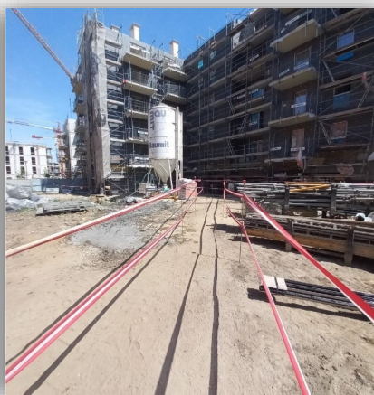
Wyznaczone ciągi komunikacyjne Poznań Enter II-III
