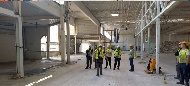
Łódź Zenit - prace na wysokości
