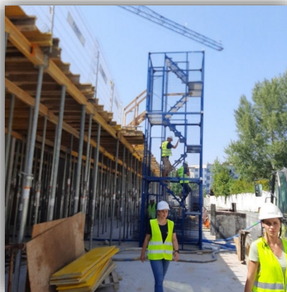
Schodnia zewnętrzna do komunikacji Warszawa Rytm I Kabaty
