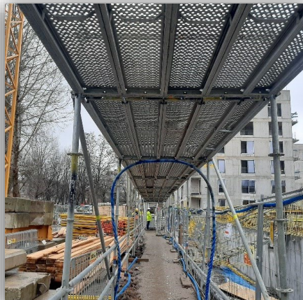
Zadaszenie ochronne nad ciągiem komunikacyjnym Łódź Fuzja F / etap A
