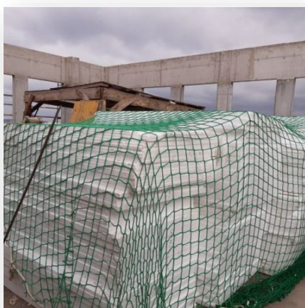
Zabezpieczenie materiałów na dachu przed działaniem wiatru Brain Park
