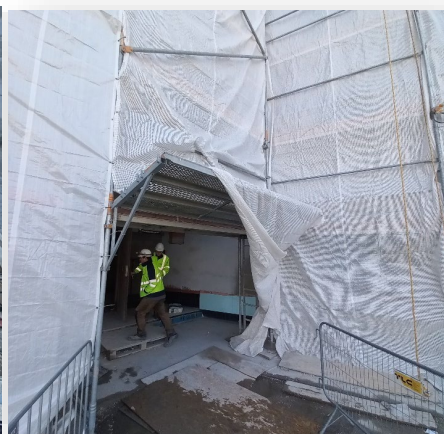
Daszek nad wejściem do budynku ZAM I
