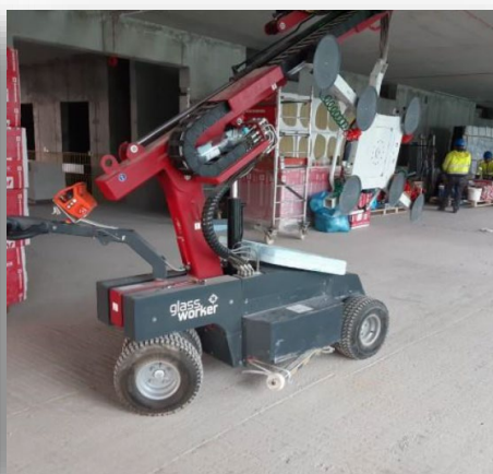
Zdalnie sterowany podnośnik wykorzystywany do montażu elementów elewacji Brain Park
