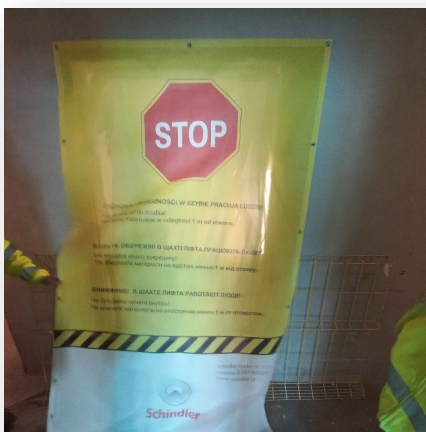
Zabezpieczenie robót w szachcie windowym ZAM I
