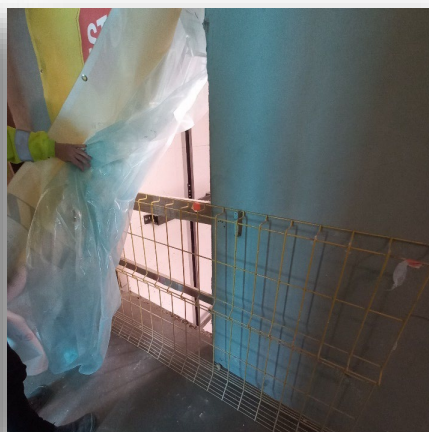
Zabezpieczenie robót w szachcie windowym ZAM I
