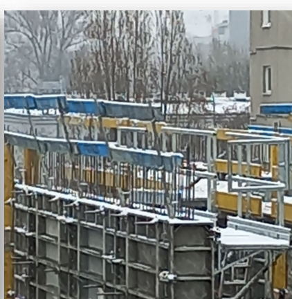
Falbiny (konsole) z obarierowaniem po dwóch stronach ściany szalunkowej Jaworska R4R
