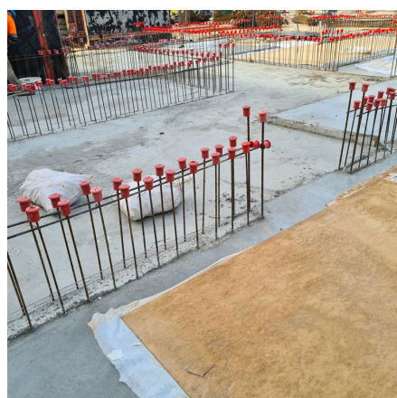
Zabezpieczenia na prętach zbrojeniowych
