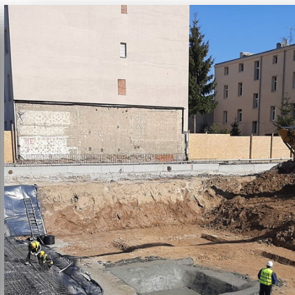
Skarpowanie wykopu Wodna III BOHO
