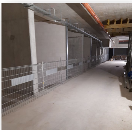
Zabezpieczenie krawędziowe w garażu KRK II
