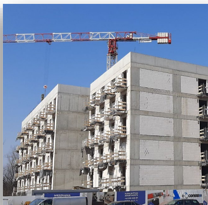
Zabezpieczenie balkonów R4R Białej Floty
