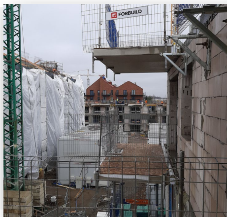
Obarierowanie tymczasowe krawędzi balkonów Enter II-III
