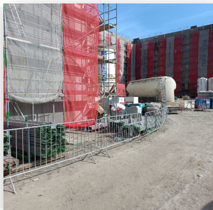
Wydzielona strefa niebezpieczna przy budynku oraz ciąg komunikacyjny 3 maja R4R
