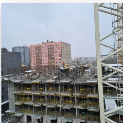
Falbiny (konsole) z obarierowaniem po dwóch stronach ściany szalunkowej Jaworska R4R
