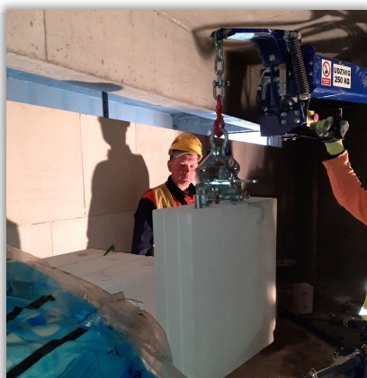
Podnośnik mechaniczny do bloczków Bonarka Living
