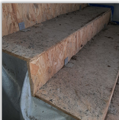
Zabezpieczenie schodów Bonarka Living
