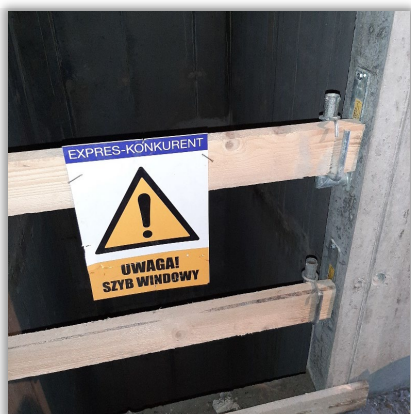
Systemowe zabezpieczenie otworów w szachtach KRK I
