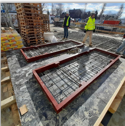
Forma do płyt drogowych po pozostałości betonu Stacja Wola II
