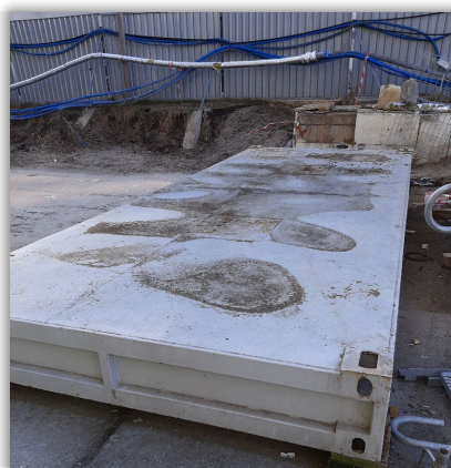
Zbiornik na ścieki pod kontenery KRK I & II
