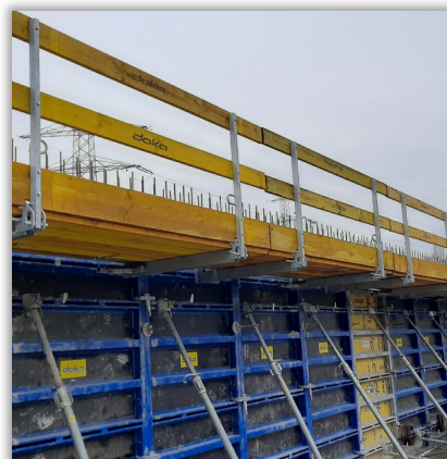
Systemowe podesty betoniarskie Stacja Wola II
