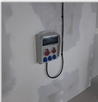
Rozdzielnice budowlane nowego typu Moje Miejsce II
