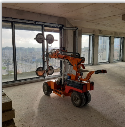
Chwytki samobieżne (transport przeszkleń) React I
