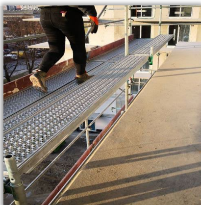
Rusztowanie elewacyjne (praca na balkonach)
