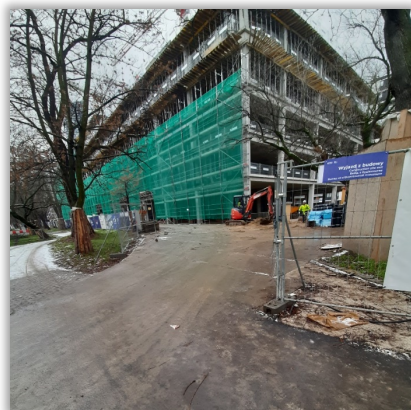
Ogrodzenie ułatwiające widoczność kierowcom
