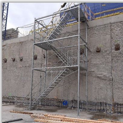
Schodnia do wykopu Brain Park
