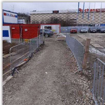
Wydzielenie parkingu poza budową Bonarka Living
