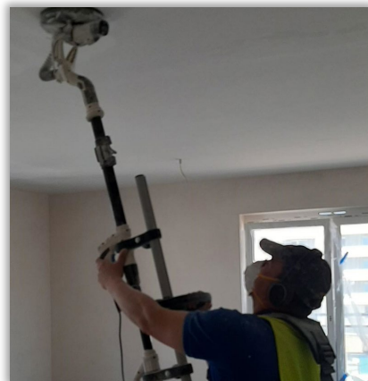
Szlifowanie z odsysaczem pyłów Archicom
