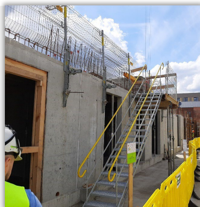
Schodnia na strop Fuzja A
