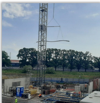
Trawers do transportu zbrojenia Archicom
