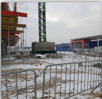
Wygradzenie strefy niebezpiecznej wokół budynku płotkami przestawnymi Widzewska Zenit I
