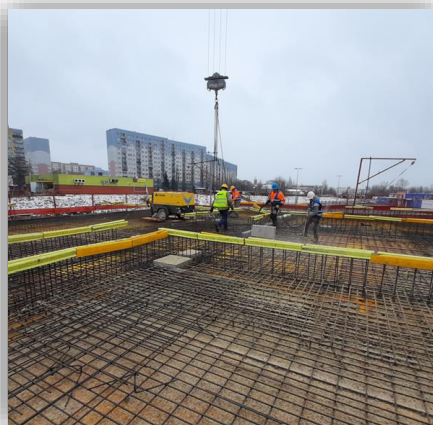
Wubudowanie Safety Blocków (zabezpieczenie otworów technologicznych) Widzewska Zenit I
