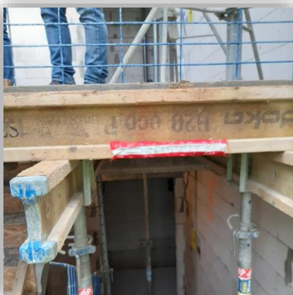
Taśma ostrzegawcza na dźwigarze szalunkowym Enter II-III
