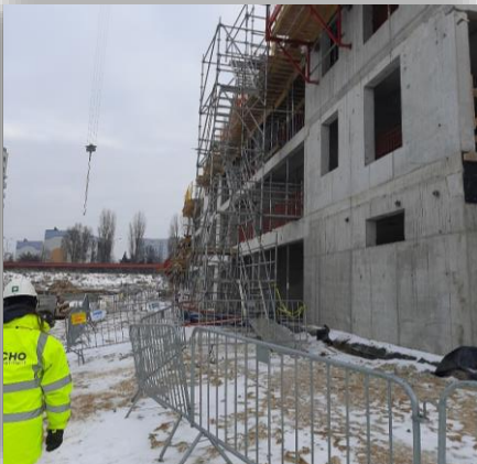
Wygradzenie strefy niebezpiecznej wokół budynku płotkami przestawnymi Widzewska Zenit I
