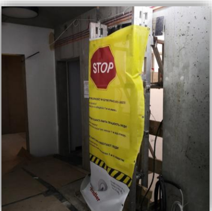
Oznakowanie i zabezpieczenie szybów windowych (wykonawca Schindler) Stacja Wola II
