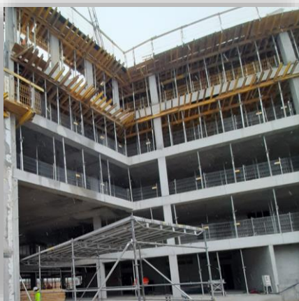
Dach ochronny przed wejściem do budynku Brain Park
