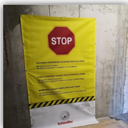
Oznakowanie i zabezpieczenie szybów windowych (wykonawca Schindler) Stacja Wola II
