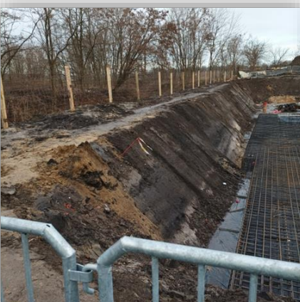
Skarpowanie wykopu szerokoprzestrzennego Archicom - Racławicka
