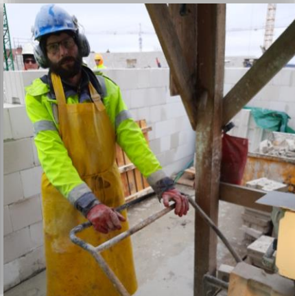
Pracownik stosuje podczas cięcia błoczków odpowiednie Środki Ochrony Indywidualnej Enter II-III
