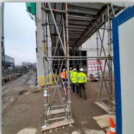
Dach ochronny nad wejściem do budynku Lobos Akademik
