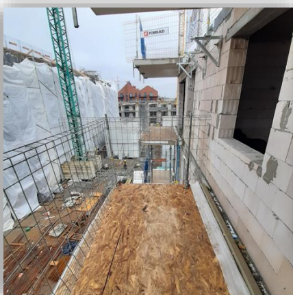
Obarierowanie tymczasowe krawędzi balkonów Enter II-III
