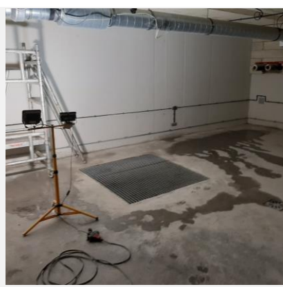
Docelowa kratka na przegłębieniu technicznym Fuzja
