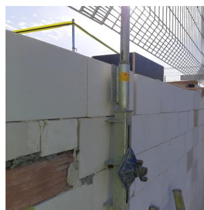
Zabezpieczenia krawędzi na murowanych ścianach KRK I
