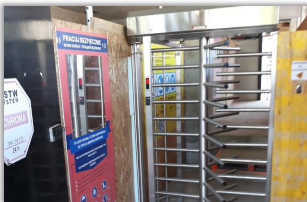
Bramka „stadionowa” – szczelne zabezpieczenie Taśmowa II
