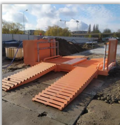
Myjka do samochodów wyjeżdżających z budowy Bonarka Living
