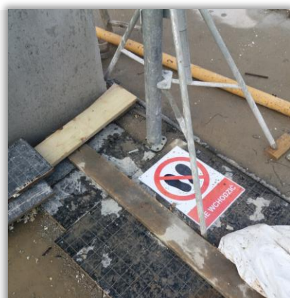
Oznakowanie na pokrywie otworu stropowego Nasze Jeźyce I
