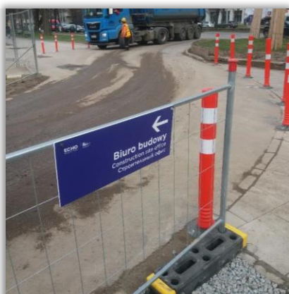
Zabezpieczenie wjazdu ciężarówek i kierujący ruchem MidPoint 71
