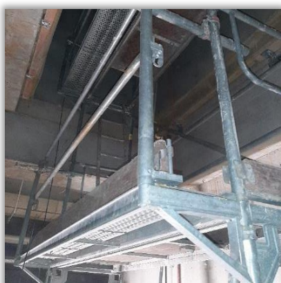
Rusztowanie w szachcie instalacyjnym Esencja
