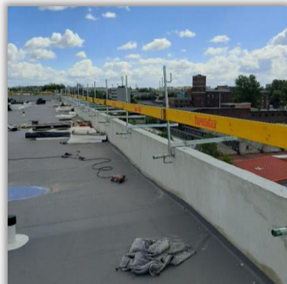
Zabezpieczenie na attyce dachu Fuzja
