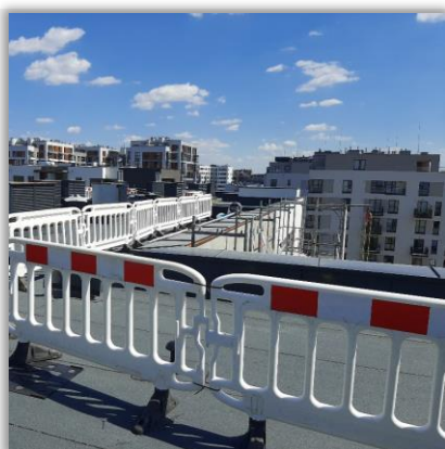
Wygrodzenie strefy niebezpiecznej na dachu Woronicza/Suwak R4R
