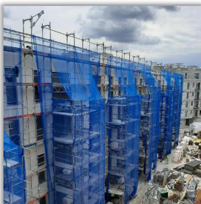
Podwyższone rusztowanie do zabezpieczenia robót na dachu Esencja
